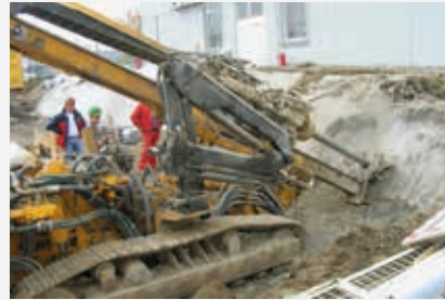
Injektion unter die bestehenden Bebauung
