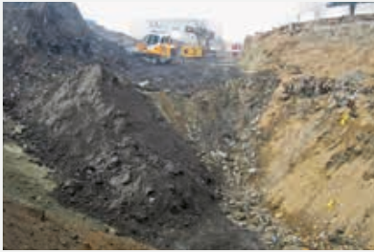
Räumung des kontaminierten Materials
